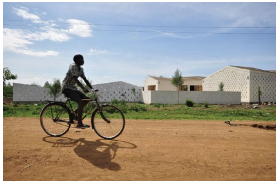
Figura 40. Foto do primeiro pavilhão construído Fonte: Pavilions for Okana.
