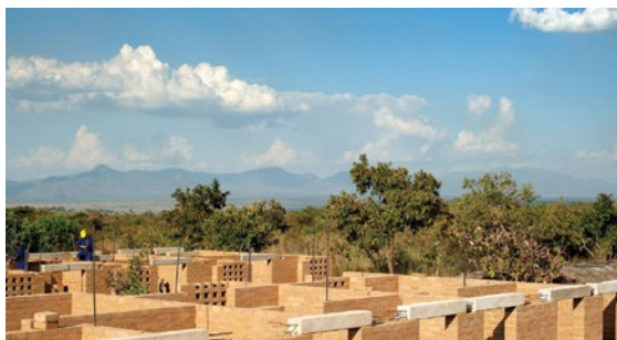
Figura 38. Foto da construção da Escola em primária em Karamoja. Fonte: Studio FH.
