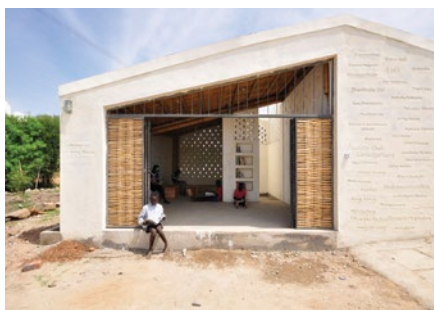
Figura 41. Foto do primeiro pavilhão construído. Fonte: Pavilions for Okana.
