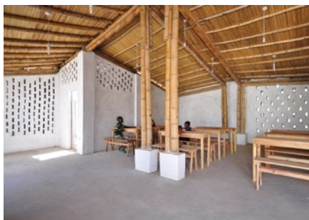
Figura 42. Foto do primeiro pavilhão construído. Fonte: Pavilions for Okana.
