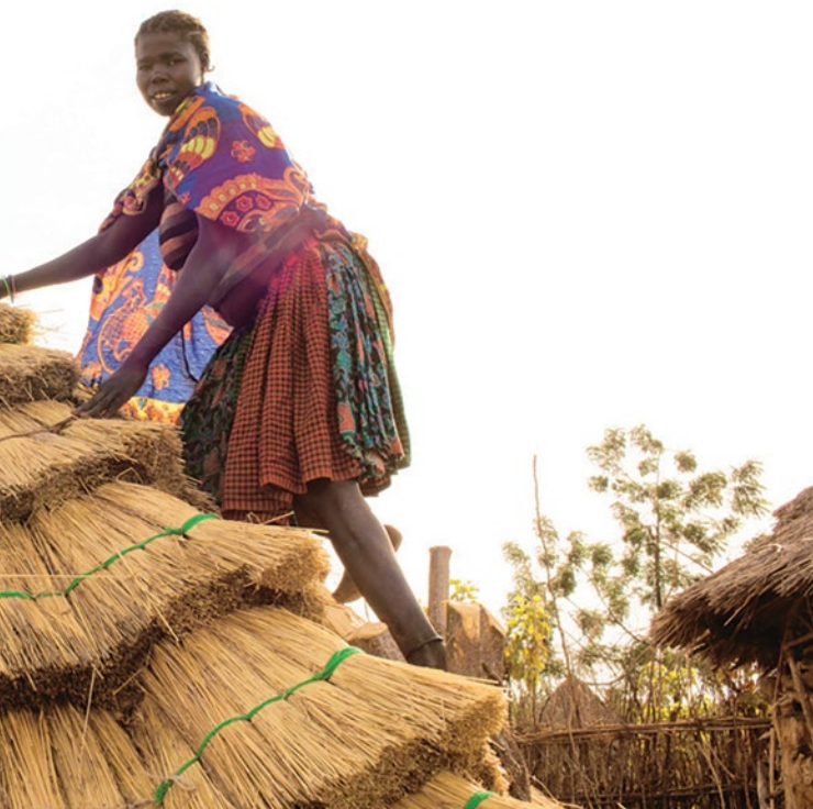
Figura 12. Mulher em Karamoja revestindo a cobertura de sua casa. Fonte: Cristian Mission Aid.
