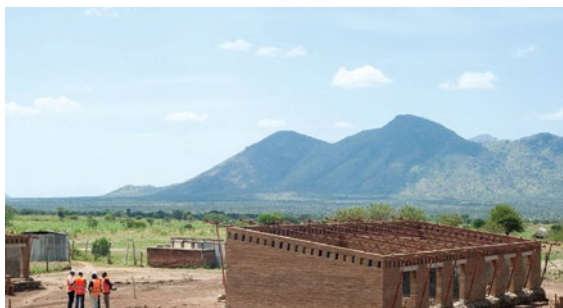
Figura 37. Foto da construção da Escola em primária em Karamoja. Fonte: Studio FH.
