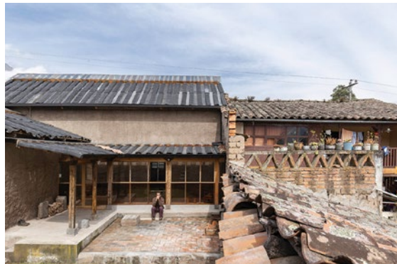
Figura 43. Foto do projeto finalizado. Fonte: Al Borde.
